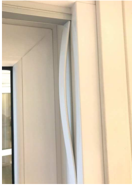
Bruk huggjern for tar av deksel list på passiv side av dør
